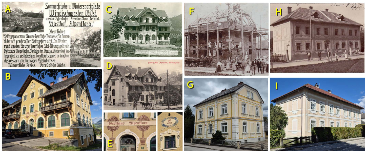
A: Werbeanzeige für das Hotel „Alpenflora“ B,C,D: Die Alpenflora 2025, bzw. um 1909 E: Florale Stuckarbeiten an der Alpenflora, typische Jugendstiltür F: Rohbau „Hirschenauerhaus“, 1907. Die Alleeabäume sind schon gesetzt. G: „Hirschenauerhaus“, 2025 H, I: Haus Römerweg 1 + 3, vor 1910, bzw. 2025 J: (rechts oben): Oft verwendetes Jugendstil-Muster, der sogenannte „Peitschenhieb“
